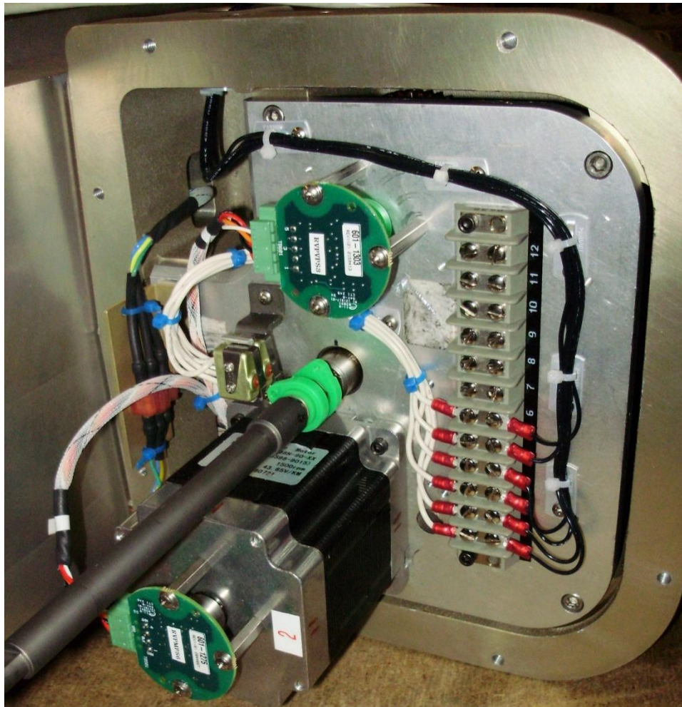
圖 2-18. 致動器限制開關導管輸入：左上角
